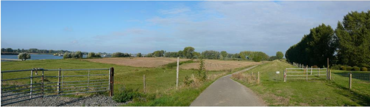
BESTAANDE SITUATIE: langzaam verkeer route onderaan de dijk
