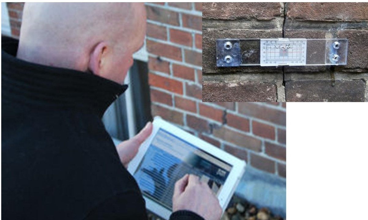
Figuur: Bouwkundige opname, scheurmeter (inzet)
